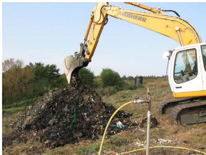
Abb. 6.4: Kettenbagger am Schurf S 1.
