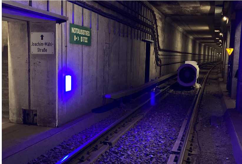
Abbildung 3: temporäre Belüftungsanlage in einem U-Bahntunnel in Hamburg
